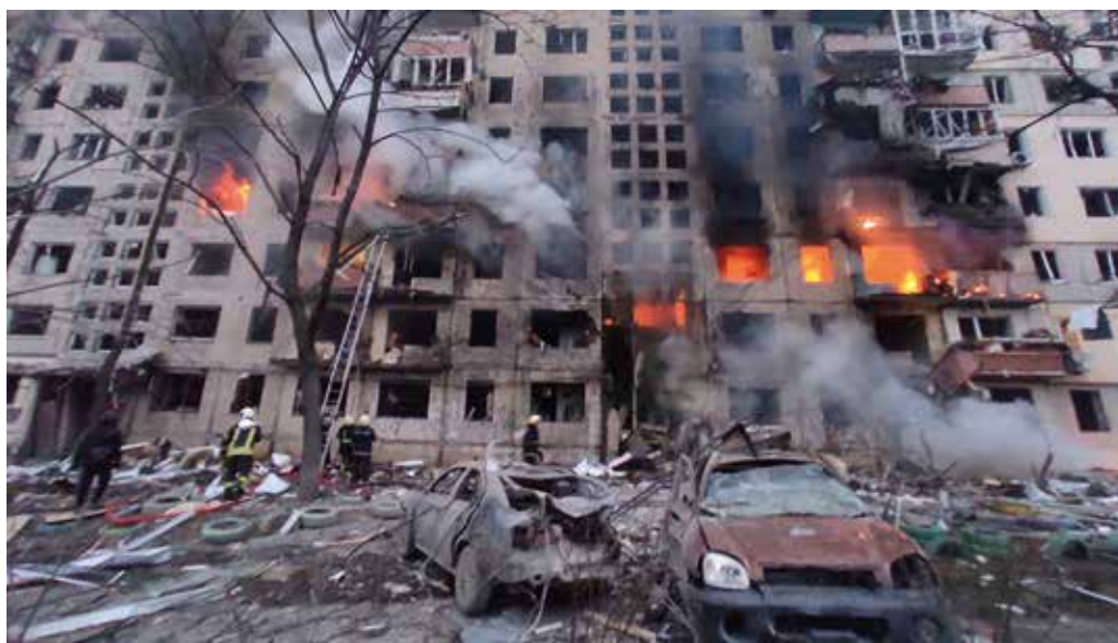
Beschossener Wohnkomplex am 14. März 2022 in Kiew (Bohatyrska-Straße).
