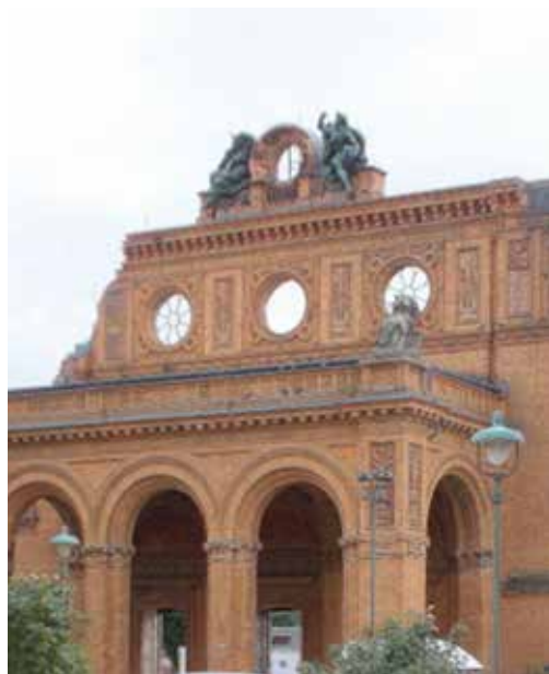
Ruine des ehemaligen Anhalter Bahnhofs, Portal des künftigen Exil-Museums, vis-a-vis der Dokumentation SFVV
