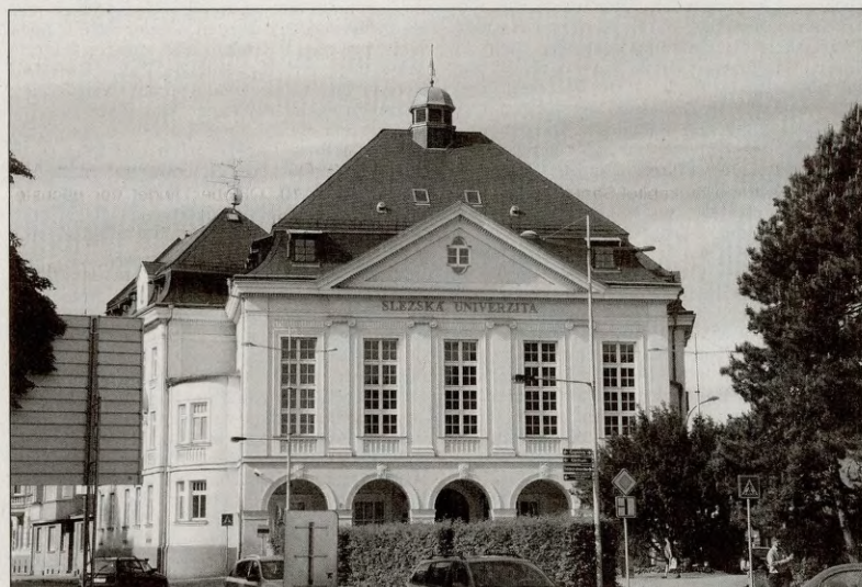
Bild links: Die schlesische Universität in Troppau. – Bild rechts: Der wiedererstandene Wallfahrtsort Zuckmantel.
